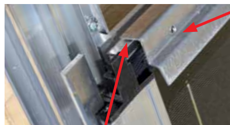
Steg der Blecheinhängeschiene hier anlegen
